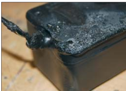
Ausgebrannter Trafo durch Verwendung von Fremdkartuschen
